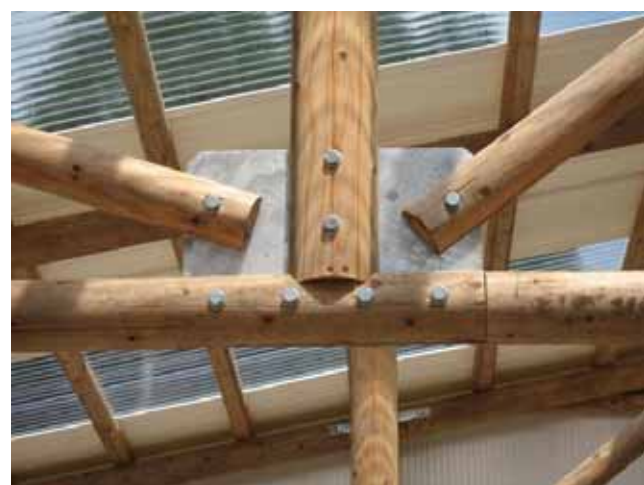
実用新案を取得した金属接合板の例
