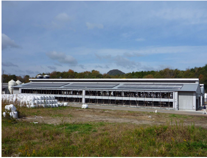
牛舎の屋根に設置した太陽光パネル（1）
