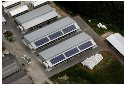
牛舎の屋根に設置した太陽光パネル（2）
