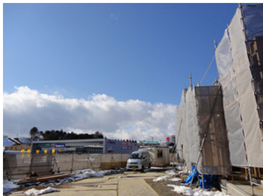
建設が進むハム工房都路
