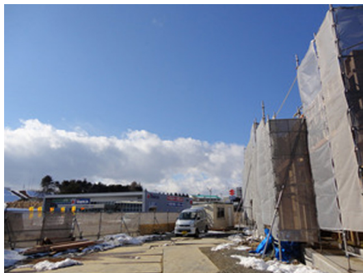
建設が進むハム工房都路
