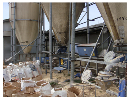
飼料タンク下部のホッパーが外れタンク内の餌が全て外部に
