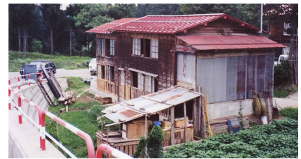
古い豚舎を改築した隔離豚舎の建設
