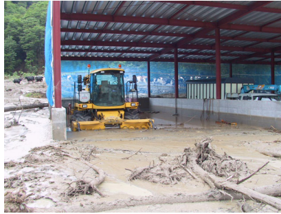
機械庫も土砂が流入し、50cmほど堆積した
