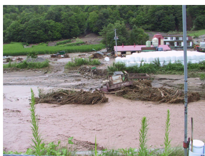
土砂のほか流木等が堆積した
