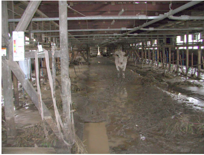
土砂が流入した牛舎内部
