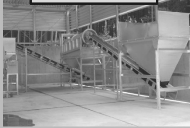
TM袋詰め設備
