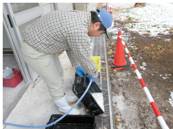
(写真8) 消毒槽の交換
