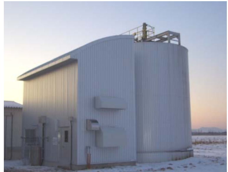
バイオガスプラント
