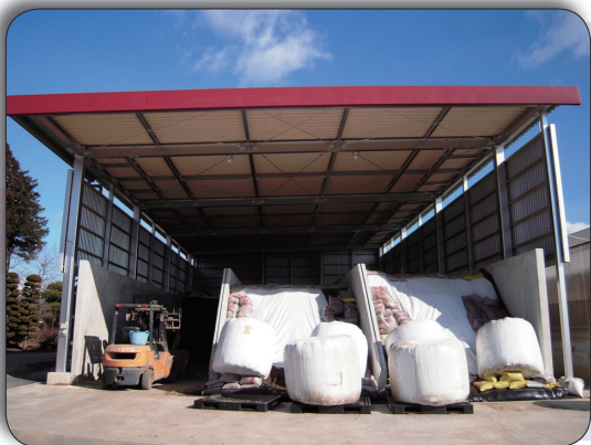
▲バンカーサイロ (幅 3.5m × 高さ 3m × 奥行き 20m × 3 基)
