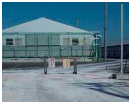
立入禁止看板と消石灰帯
