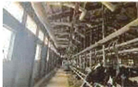
送風ダクトから乾いた涼しい風が出てくる。効果的に冷やすために排出口の角度を調整して牛の頸動脈付近に風を当てる
