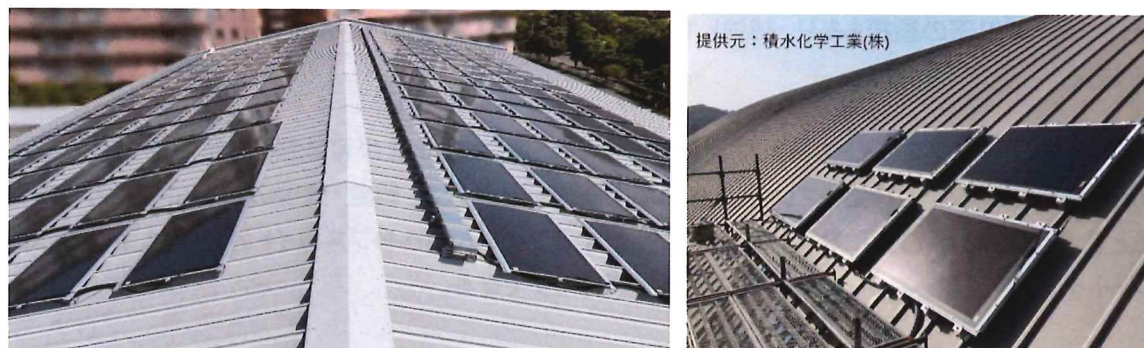
写真 4 体育館の屋根に設置したフィルム型ペロブスカイト
