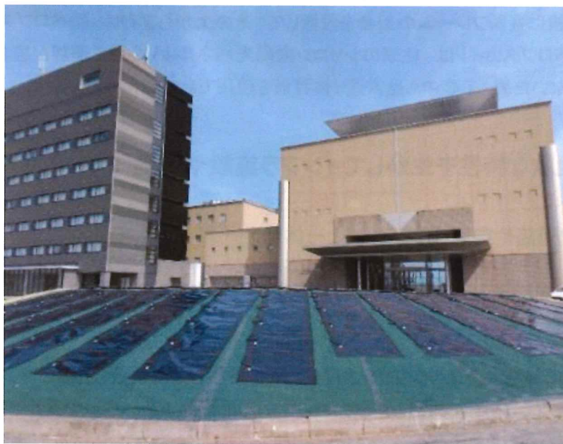
写真5 芝生面の防草シートとフィルム型ペロブスカイトを組み合わせた実証実験
