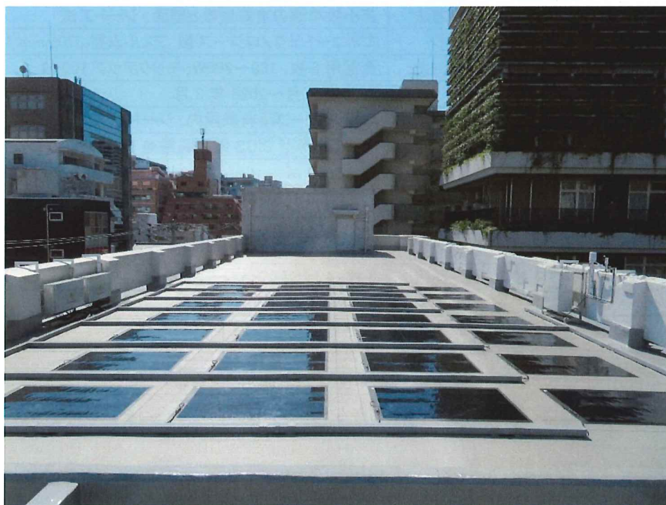
写真14 防水材一体型ペロブスカイト太陽電池の実証実験
