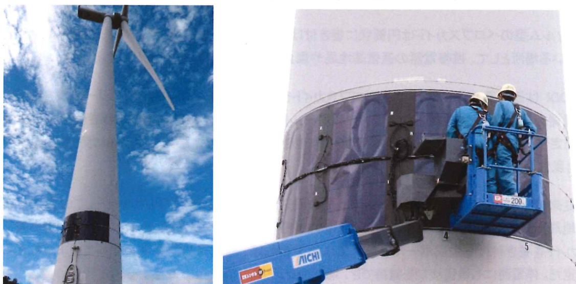
写真 8 風車タワーに設置したフィルム型ペロブスカイト
