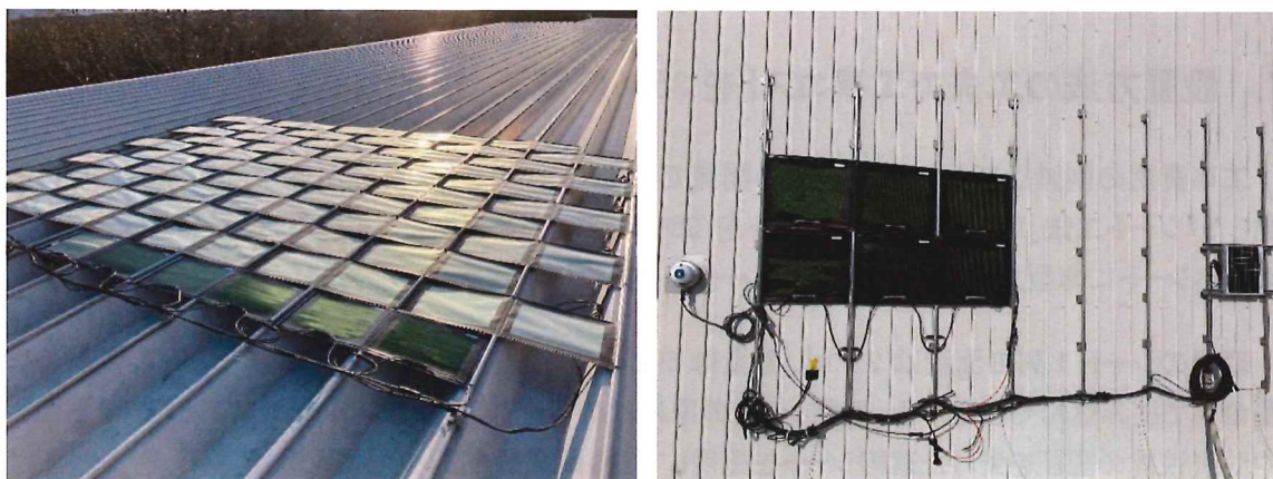
写真 11 苫小牧埠頭におけるシート工法の実証実験 折板屋根(左)、凸部のない壁面(右)
