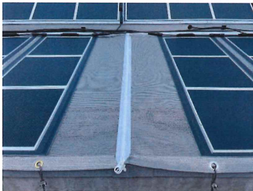
写真 13 「ファスナー取り外し式工法」の実証実験の様子 ファスナーでシートを連結(左)、ファスナーでシートの両端を固定(右)
