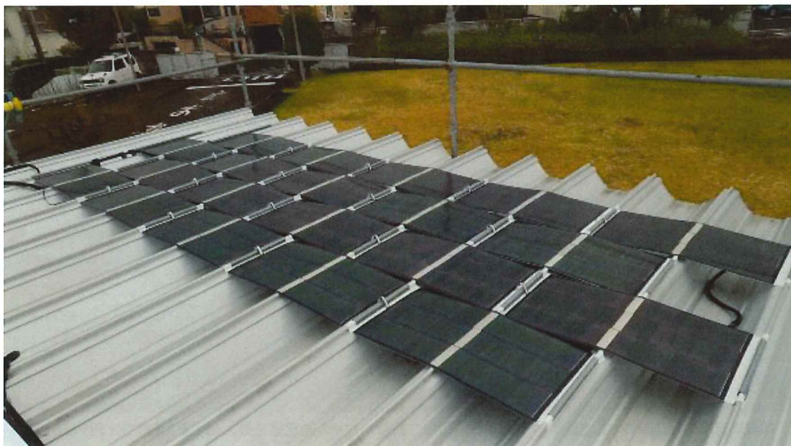
写真 12 CIGS 系太陽電池を用いたシート工法の実証実験
