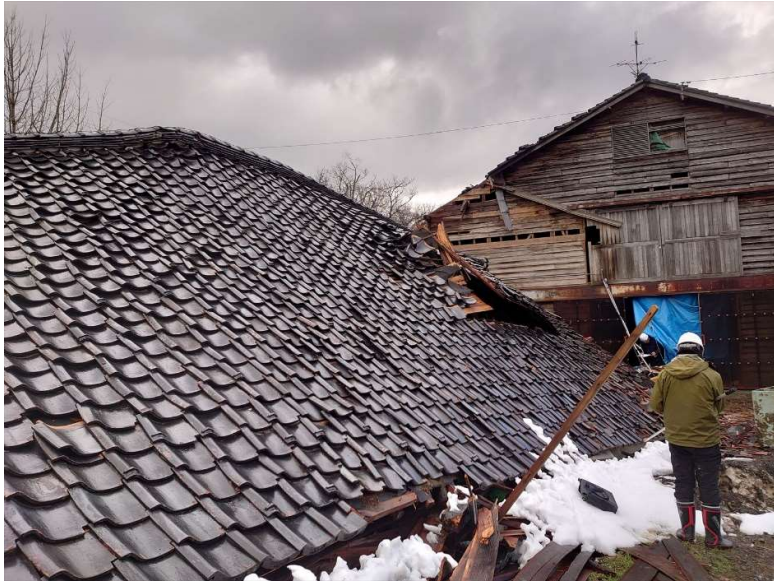
倉庫の破損・倒壊の様子
