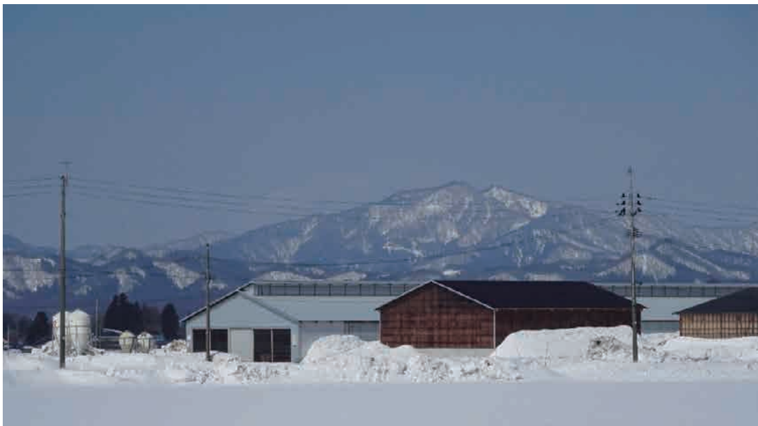
遠方からの全景
