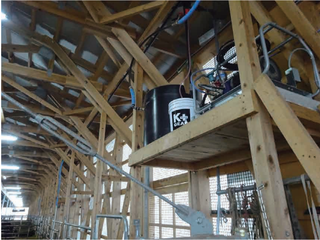
高圧細霧装置
