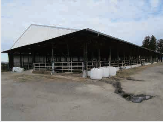
写真5 牛舎 1,039.5㎡×1棟 平成28年度畜産クラスター (施設整備事業)
