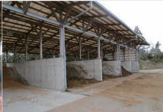
写真4 堆肥舎兼飼料庫 480㎡ (堆肥舎360㎡ 飼料庫120㎡)
