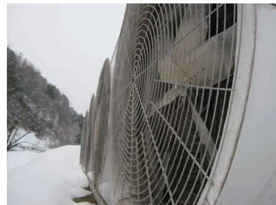
N牧場の牛舎自動換気システム
