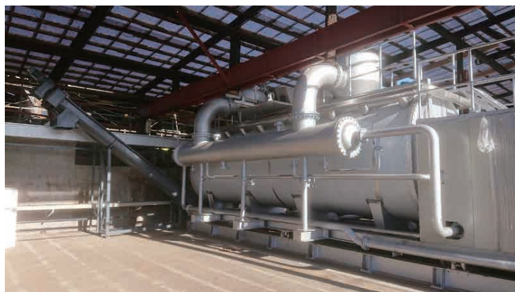
写真 3 堆肥コンポスト化装置
