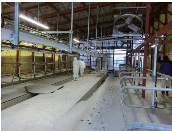
【写真1 整備工事中の搾乳牛舎 (小西農場)】
