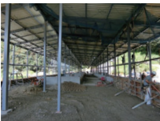
【写真2 施設整備事業を活用して建設中の新牛舎】
