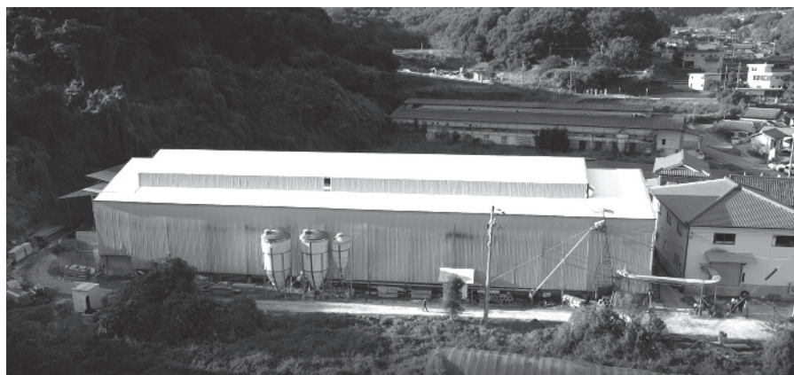
(写真2) 鶏舎外観
