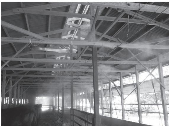
(写真7) U-motion+冷房加湿装置連動システムで噴霧器作動中
