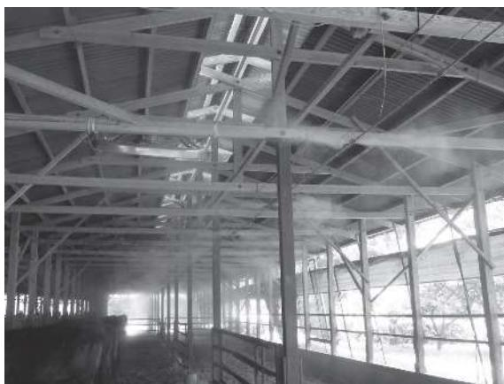
(写真7) U-motion+冷房加湿装置連動システムで噴霧器作動中
