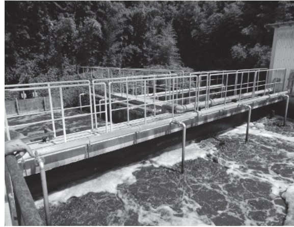
(写真8) 浄化槽 (定期的な水質検査でも排水基準をクリア)
