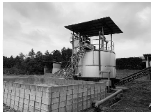
(写真7) 縦型コンポストと脱臭槽
