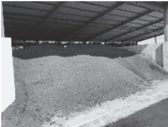
(写真7) 堆肥舎（ブロー）
