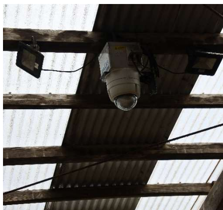
監視カメラによる分娩前後の繁殖牛による事故防止。携帯電話から監視可能
