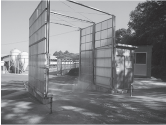
(写真4) 入り口に自動消毒ゲートを設置し車両消毒を徹底
