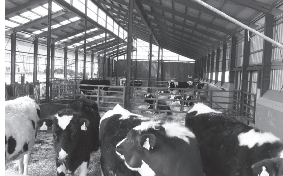
平成23年に新設した育成牛舎
