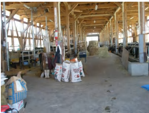
完成した繁殖牛舎内部
