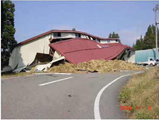
平成16年10月23日新潟県中越大地震発生 倒壊した牛舎
