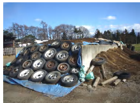
L型ブロック利用サイロ(コンクリート床)(収量に応じて設置でき、しかも低コスト)
