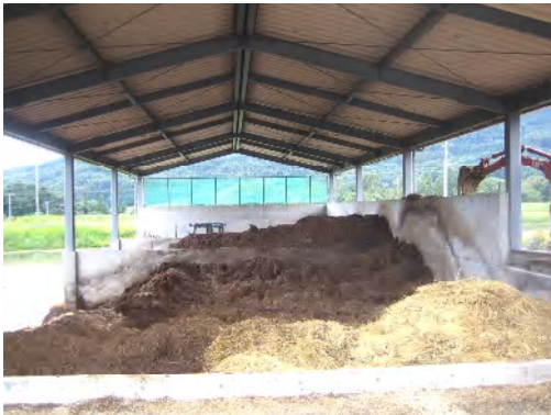
堆肥舎(作業性を重視して建設)
