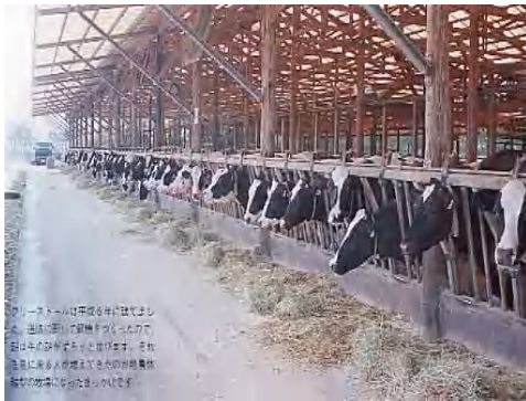
古電柱を柱に使ったフリーストール牛舎
