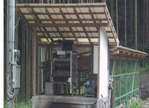
浄化槽（嫌気性+活性汚泥処理）
