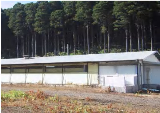
子豚舎の新規建設で作業効率が向上
