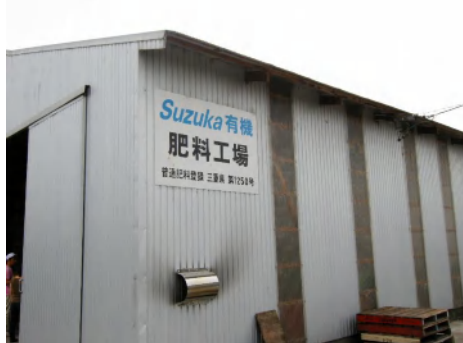
完成した肥料を袋詰めする肥料工場
