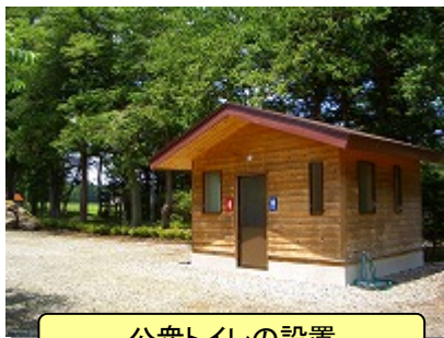
公衆トイレの設置
