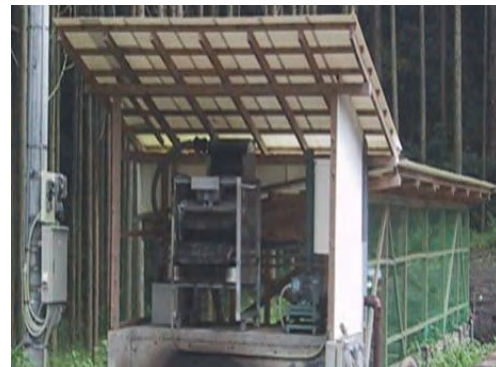
浄化槽（嫌気性+活性汚泥処理）
