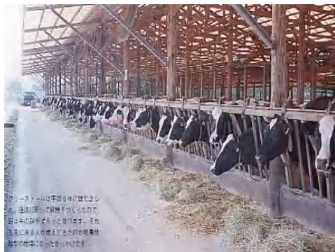
古電柱を柱に使ったフリーストール牛舎
