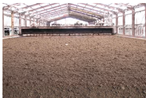
発酵乾燥施設によるたい肥化処理
