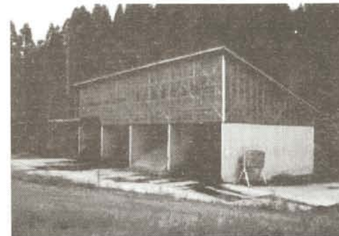
堆肥センター
