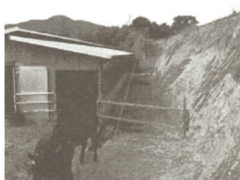
開削による牛舎の換気改善 赤線は開削前)
