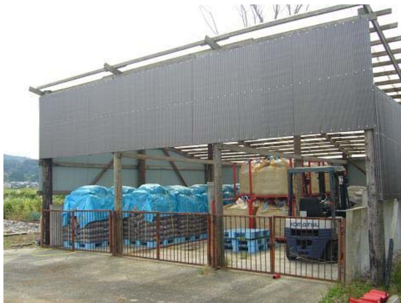
堆肥保管施設
