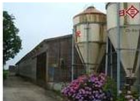
生産堆肥保管施設
