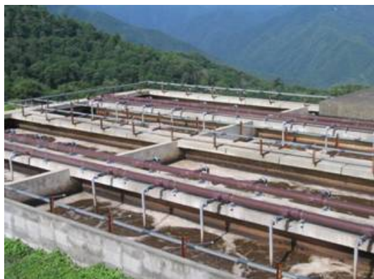
尿汚水の曝気槽
