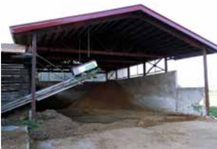
敷地内のたい肥舎
