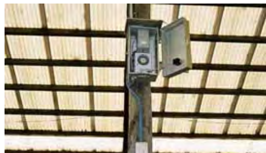
エアレーションはタイマーで管理
