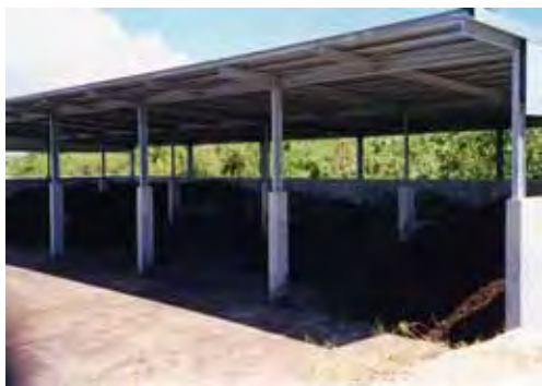
平成 16 年に建設したたい肥舎
