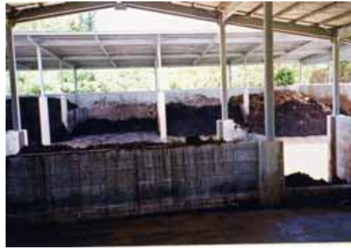
たい肥舎は牛舎と同線上に設置
