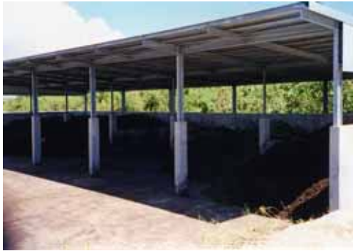
平成 16 年に建設したたい肥舎
