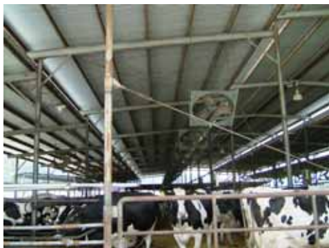
防暑と低コストを実現した3層構造屋根
