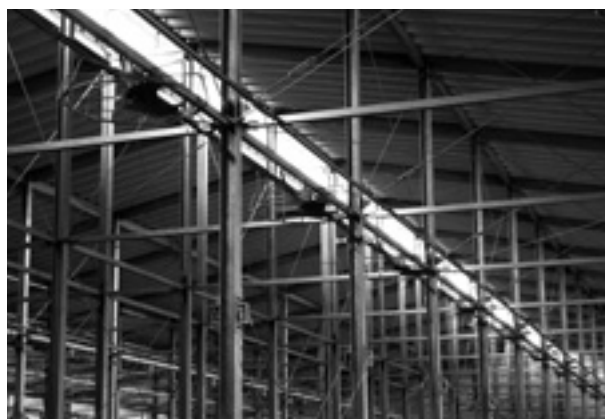
(写真3) 赤城畜産での経験を生かし天井が高く換気の優れた牛舎を建築した
