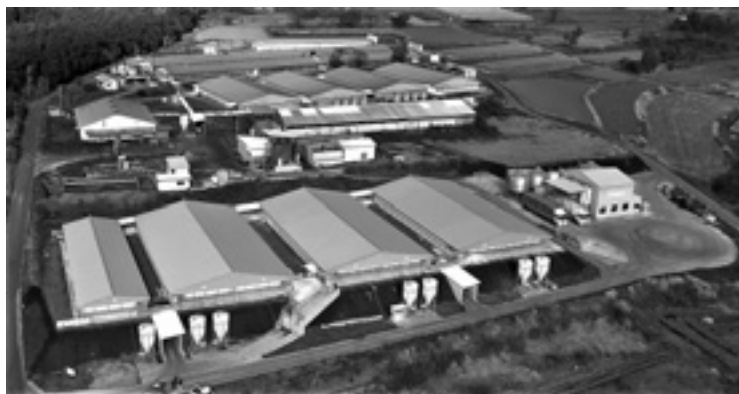
4段に造成された約2.5haの敷地に14棟の豚舎が並ぶ熊本興畜。手前が肥育舎と飼料工場、奥が繁殖舎
