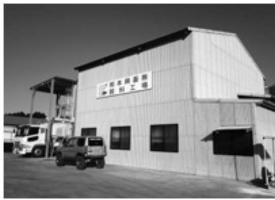
飼料の自家配合施設。現在の製造能力は母豚600規模だが、1200頭まで対応できる設計。
