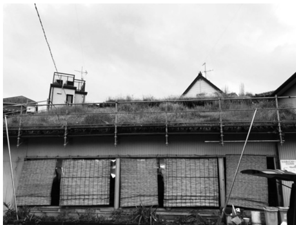
(写真1) 屋根に植物を植える屋上緑化も断熱性が高まり、舎内温度を下げるのに効果があります。
