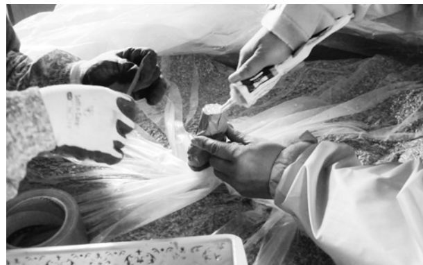
(写真8)縛り口の余剰部分を切除、ボンドでシールして空気侵入阻止
