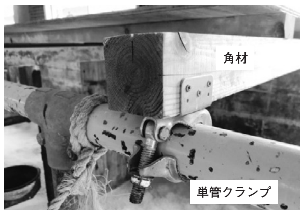
(写真3) 通路側の角材固定
