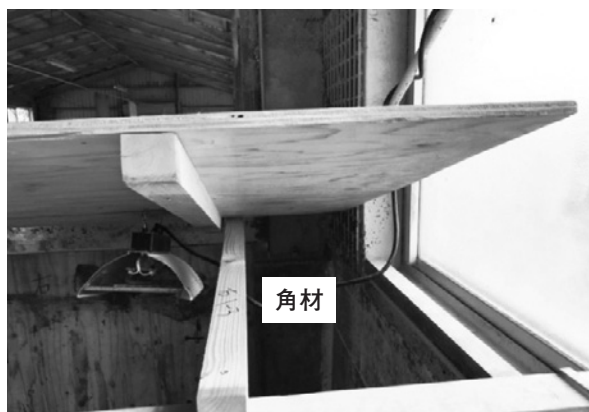
(写真5) 天井板固定
