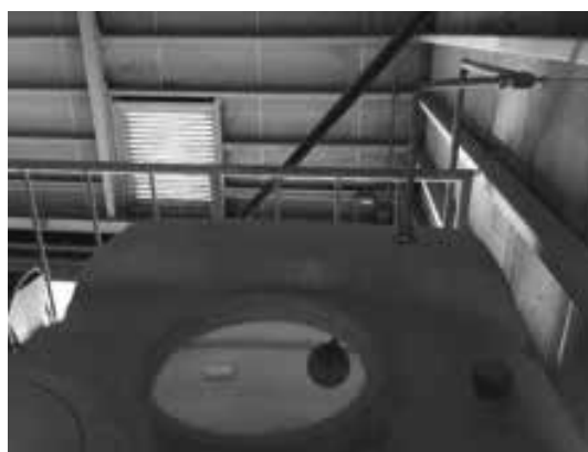
(写真17)水道水の水圧変化を避けるために高架水槽を設置
