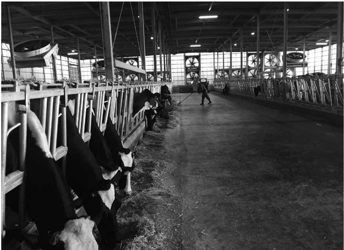
ハイブリッド式トンネル換気型の牛舎
